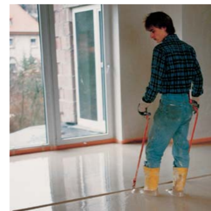
links: AFE mit hohlraumfreier Heizrohrummantelung und somit störungsfreiem Wärmeübergang rechts: Konventioneller Zementestrich
