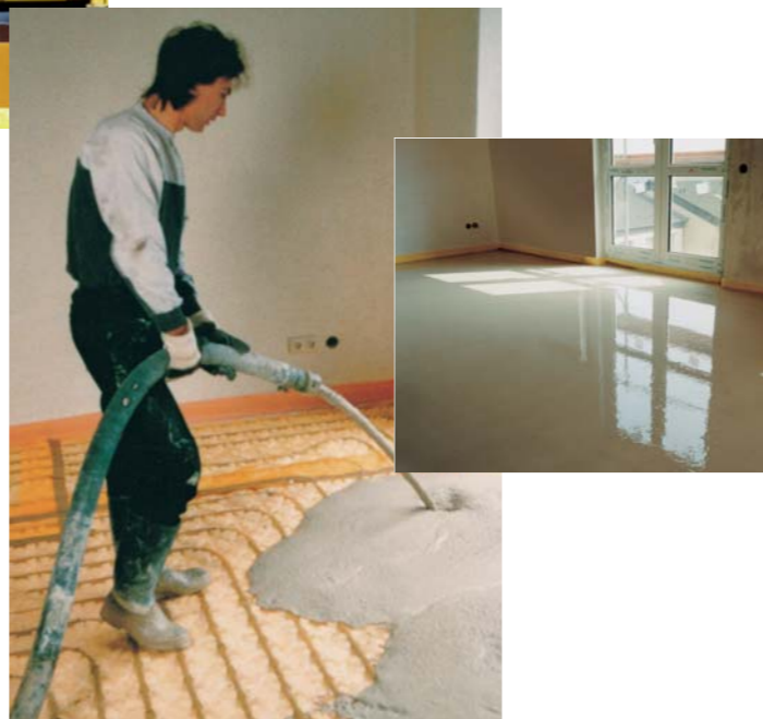
Genauso schnell, wie die fertige Estrichmischung aus dem Fahrmischer kommt, wird sie auch eingebaut.
